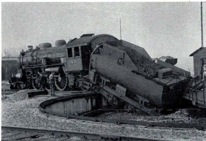
Fig. 376. E-Lokomotiv er af Sabotører kørt i Drejeskivegruben, hvorved saavel Lokomotiv som Drejeskive foreløbig er ubrugelig.
